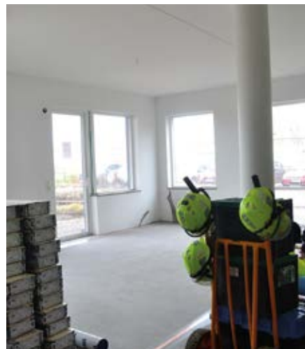
Gemensamhetslokal under uppbyggnad.
