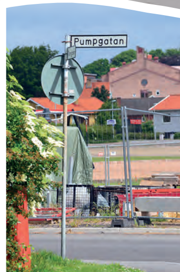
Vi bygger ytterligare 64 lägenheter med hög bekvämlighet på en tidigare parkering, i kvarteret Sjöcrona.
